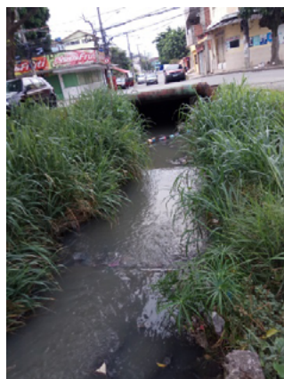
Figura 4: Acesso do Rio das Pedras ao bairro de Oswaldo Cruz pela Rua Ana Telles.
