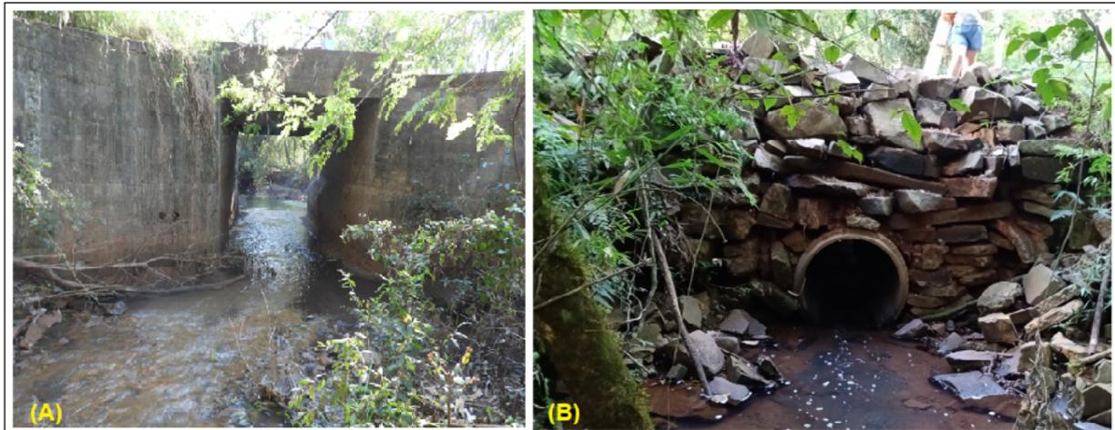
FIGURA 3: Exemplos dos bueiros estudados. A) bueiro celular (B1) (vista à montante) e, B) bueiro tubular (B5) (vista à jusante). Fonte: o autor.
