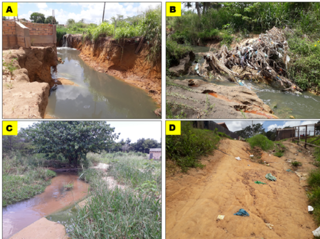
FIGURA 4: A - Construções em área de risco; B - Deposição e acúmulo de resíduos sólidos no igarapé; C - Processo de assoreamento do canal; e D - focos erosivos e lixo na área da ocupação.
