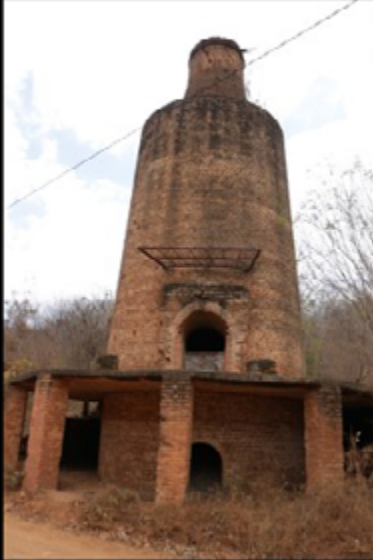
A – Forno do contínuo (Farias Brito), usado para o beneficiamento do calcário
