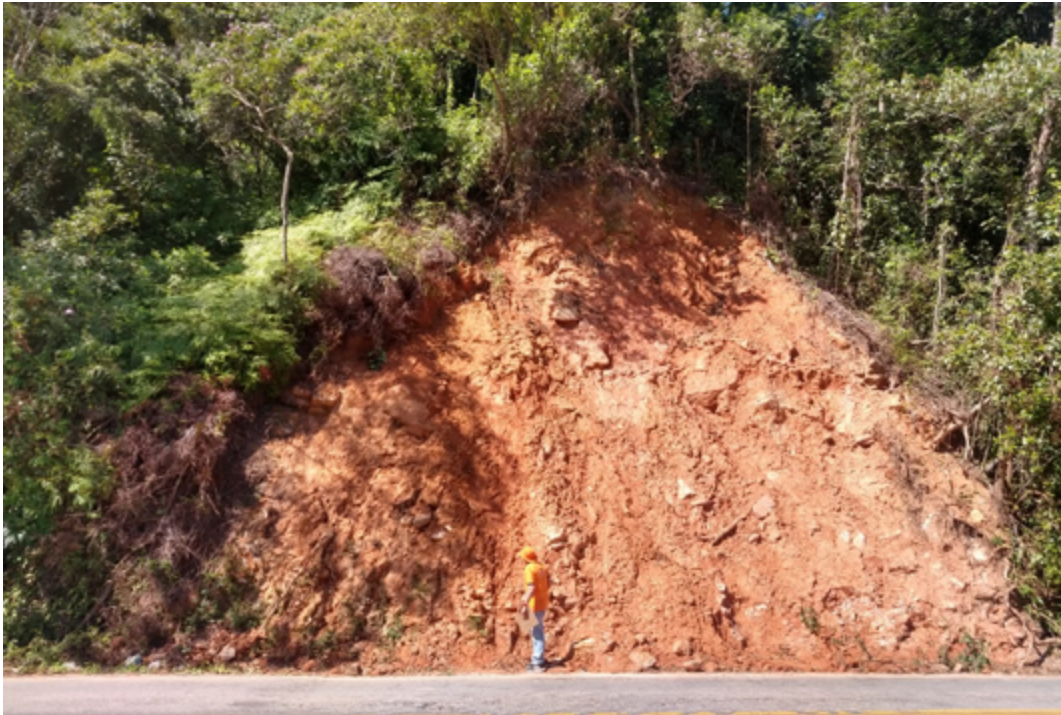
FIGURA 5: Escorregamento de grande porte localizado na rodovia, blocos de rocha métricos imersos na matriz do solo.
