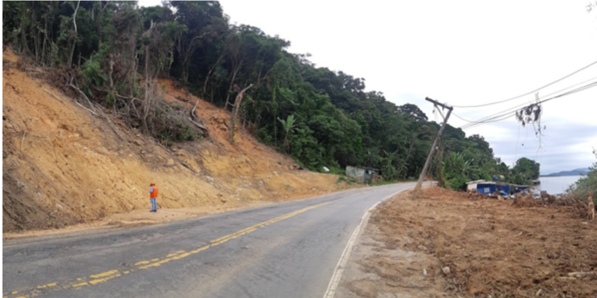
FIGURA 3: Escorregamento de grande porte que vitimou uma pessoa em moradia localizada do outro lado da pista.
