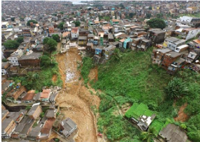
FIGURA 4: Movimento de massa no bairro Barro Branco. Encosta com 45 metros de altura. Fonte: Defesa Civil, (2015).
