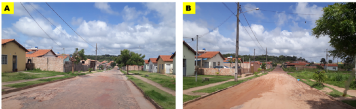
FIGURA 5: Residencial Salvação - A - Asfalto em processo de deterioração; B - Sedimentos depositados nas vias, carregado das áreas à montante. Fonte: Arquivo Pessoal.
