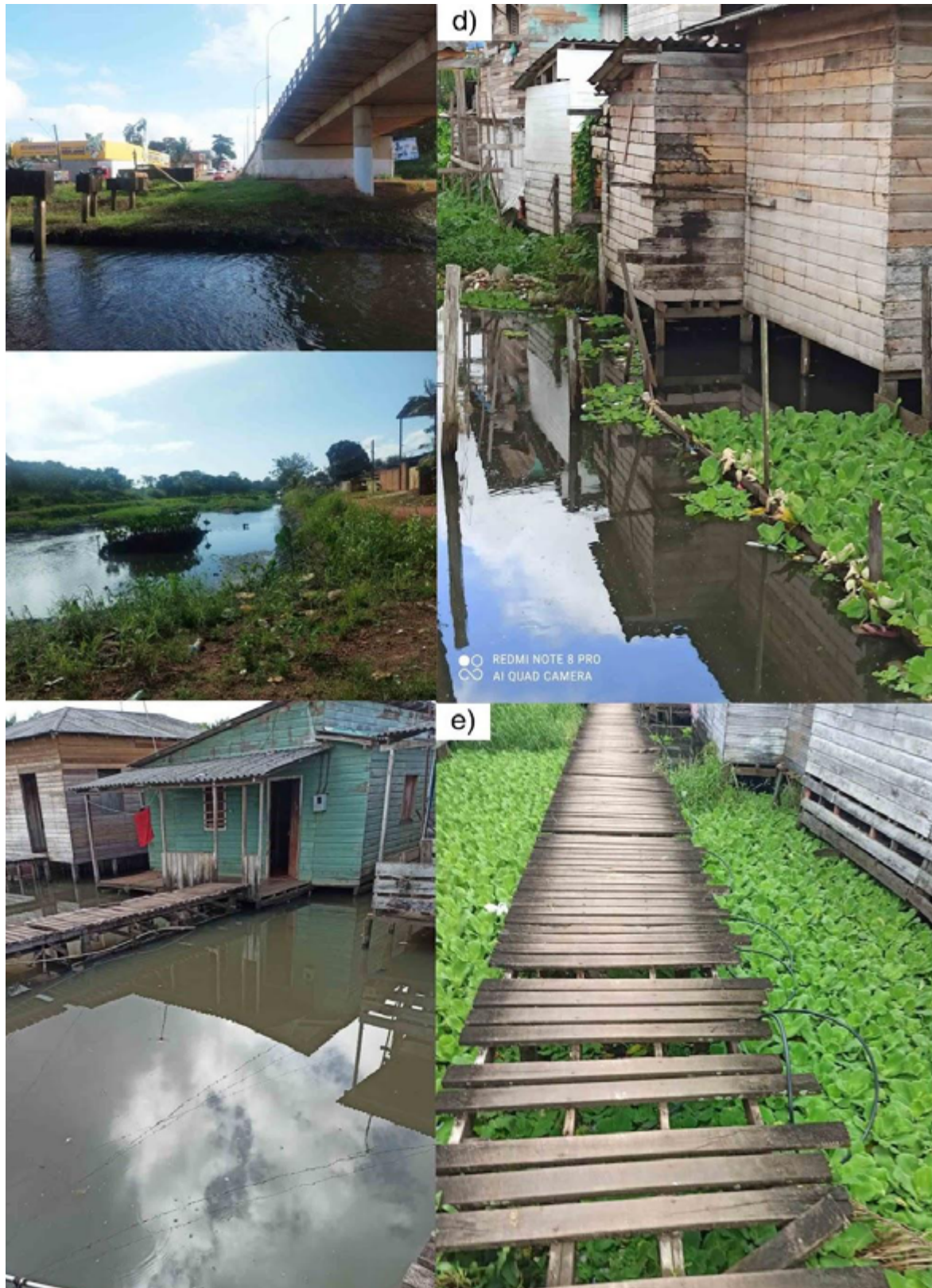
FIGURA 5: Área de Ressaca do Bairro São Lázaro (Macapá/AP). a) ocupação do entorno do Canal do Jandiá; b) resíduos e assoreamento no leito do canal; c) moradia e tubulação sobre o lago; d) banheiros que despejam dejetos na água; e) passarelas de acesso, sem manutenção. Fonte: Elaborado pelos autores (2021).
