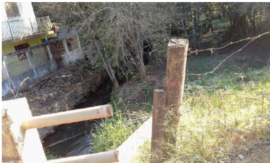
FIGURA 4: Setor central do bairro Piaí. Fonte: Arquivo dos autores.
