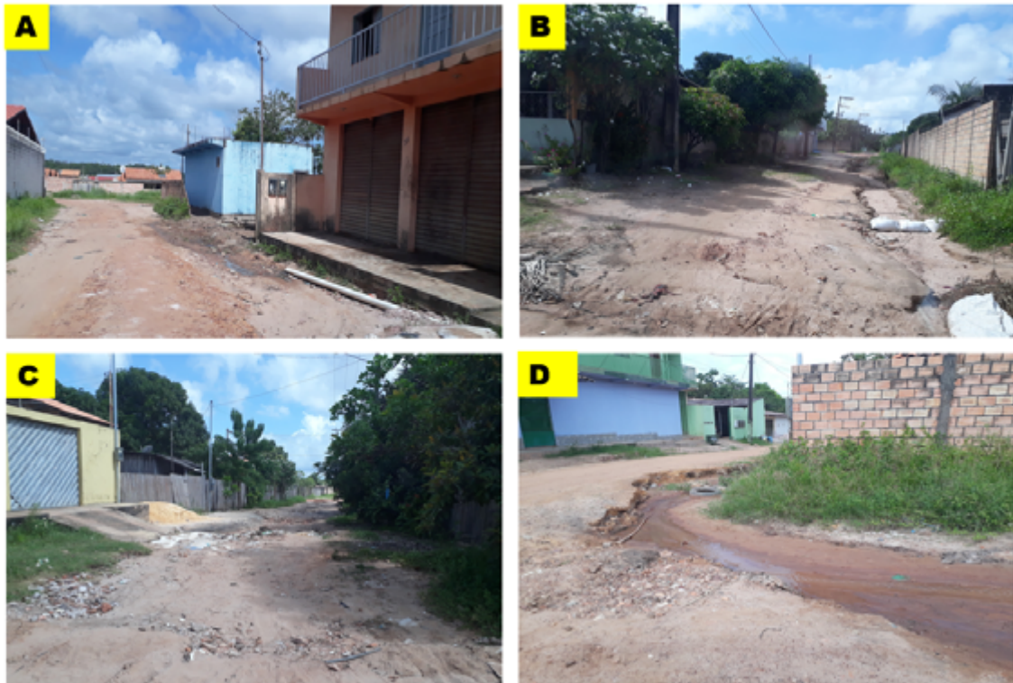
FIGURA 3: A - Disposição de esgoto domiciliar a céu aberto; B - Presença de barreiras de contenção de erosão ao longo da canaleta marginal de drenagem; C - Disposição de entulho para nivelamento da via; e D - Ausência de calçamento e processo erosivo acelerado. FONTE: Arquivo Pessoal.
