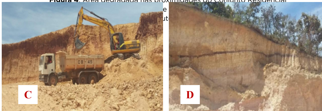
Figura 4: Área de degradação nas proximidades do Conjunto Residencial
