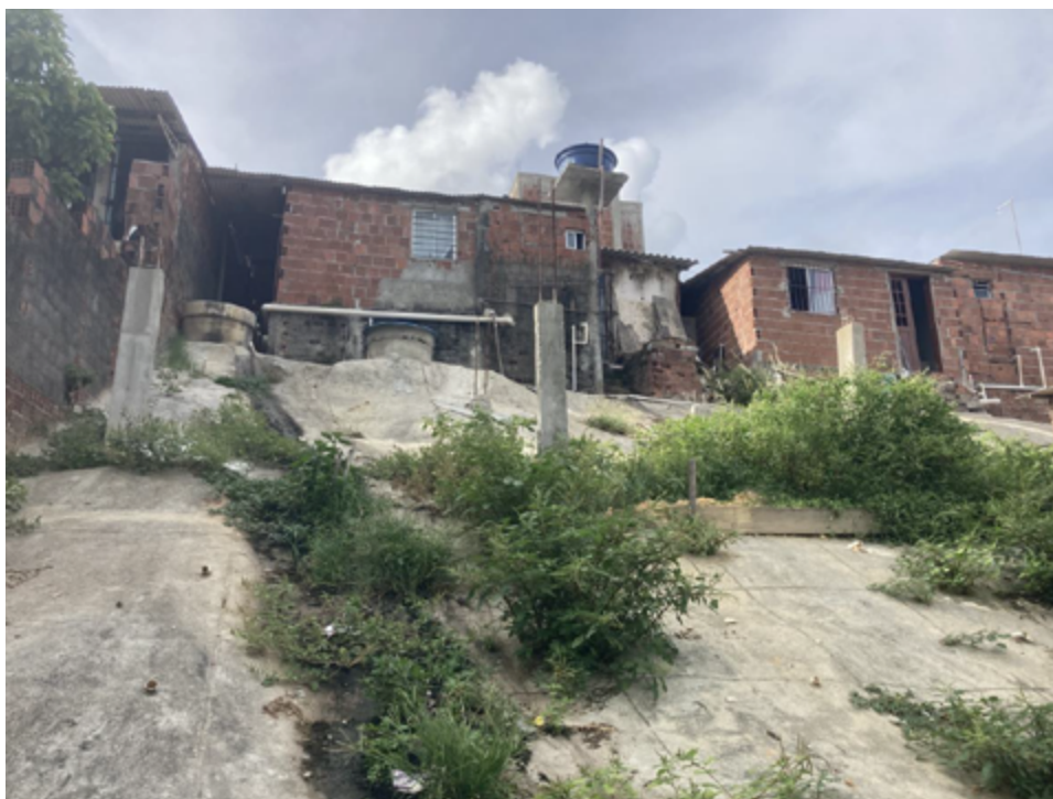
FIGURA 5: Setor de risco classificado como R1 (setor 3) pelo mapeamento participativo, localizado na rua Ceará, Bairro dos Estados – Camaragibe, com a presença de estratos vegetais e matéria orgânica devido o lançamento de águas servidas diretamente na encosta, que já possui obra de contenção.
