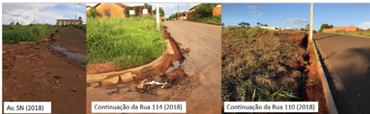
FIGURA 4: Feições erosivas no bairro Barbosa.
