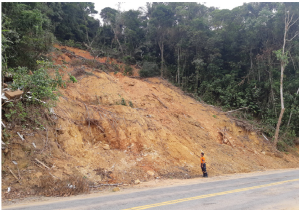
FIGURA 4: Escorregamento de grande porte deflagrado na região.
