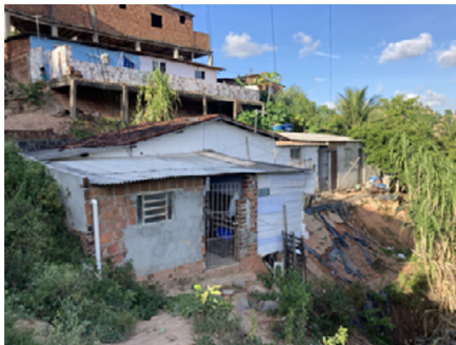
FIGURA 2: Ocupação antrópica precariamente instalada e de baixa infraestrutura com cortes de taludes para ocupação em encostas declivosas e com medidas paliativas de lonas. Fonte: Pereira (foto de 2021).
