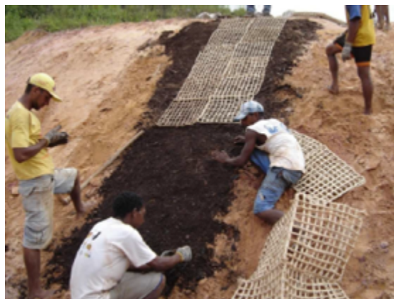
Figura 7: aplicação de técnicas de bioengenharia Fonte: Bezerra, (2011)
