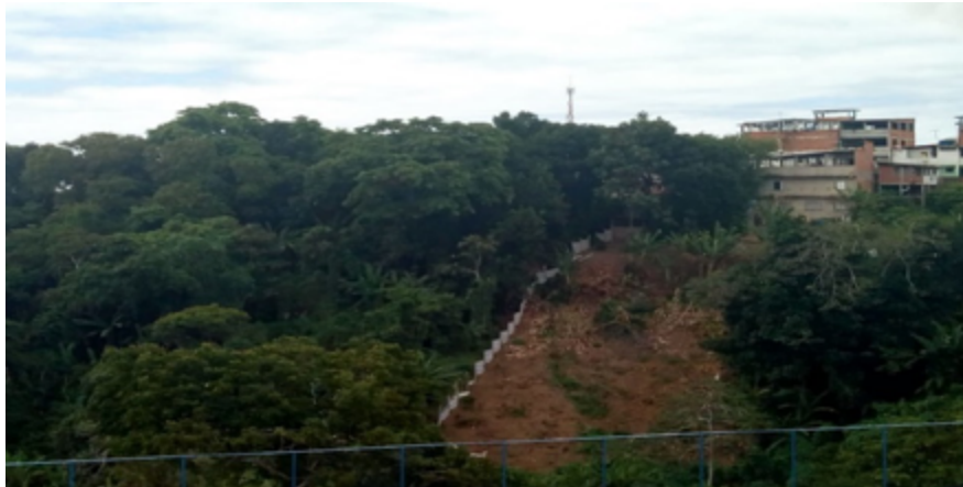
FIGURA 5: Encosta com desmatamento para exploração de solo para construção civil. Exposição de tubulação de águas servidas e exposição dos solos à deslizamentos com risco moradias adjacentes. Fonte: Grupo de Pesquisa CIPAS/RB. 2015.
