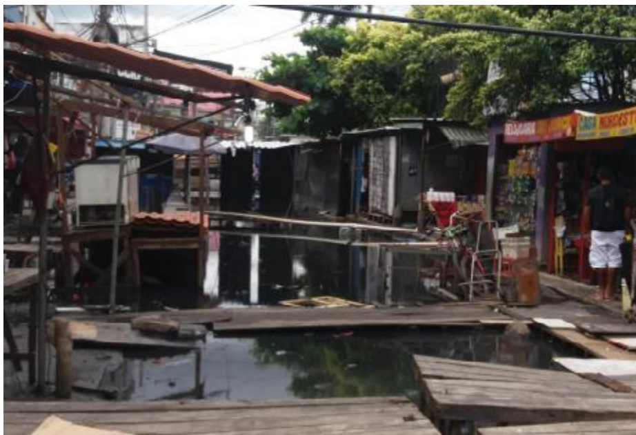
Figura 5: Calçada alagada em Rio das Pedras Fonte: Retirada pela autora
