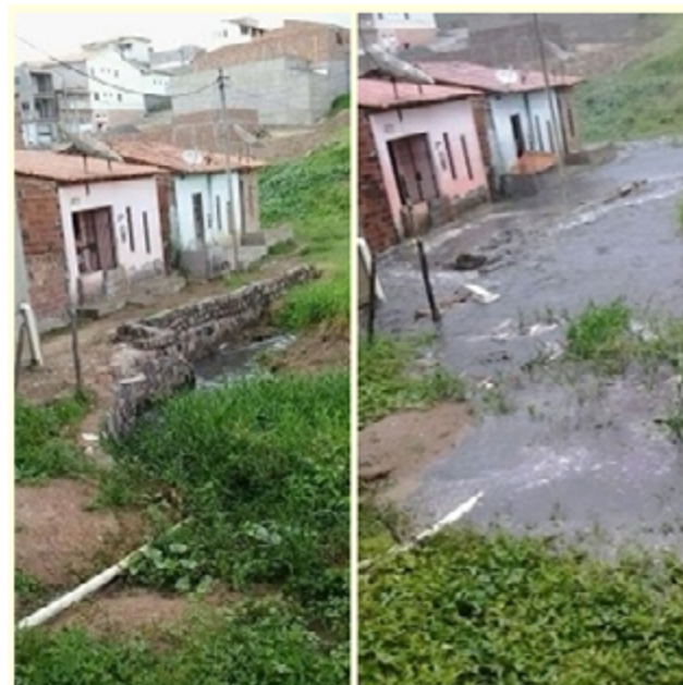
FIGURA 4: Fotografias de moradias precárias construídas indevidamente no interior da planície aluvial no Loteamento Recanto dos Prazeres. Observa-se o período anterior ao transbordamento de janeiro de 2019 (A) e no transcorrer do transbordamento em março de 2019 (B).
