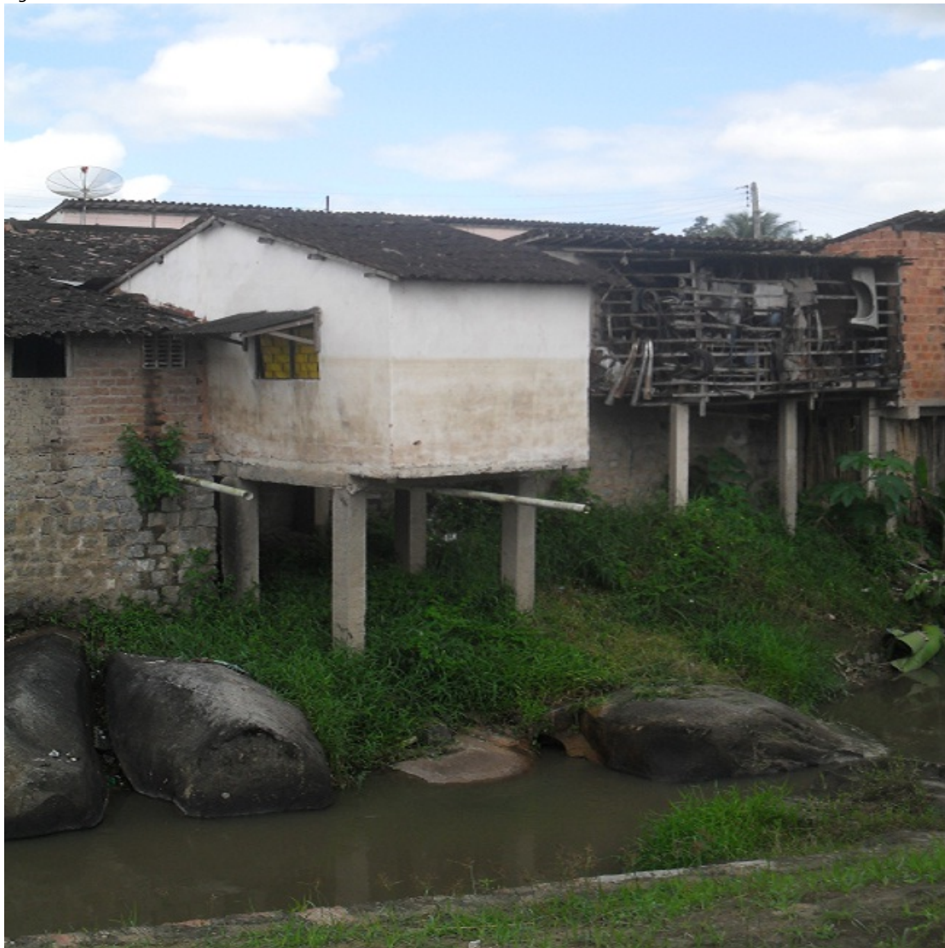
Exemplo de esgoto doméstico lançado diretamente no Rio Paraíba e marca d'água referente ao nível alcançado pelo rio durante a enchente em Cajueiro.
