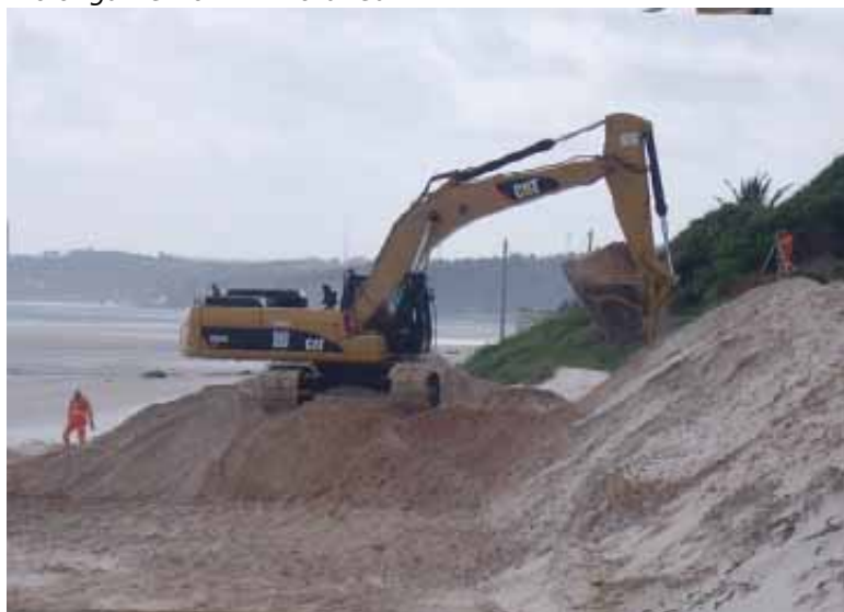
Início dos trabalhos para prolongamento da Av. Litorânea em São Luís. Fonte: Jornal Imparcial.
