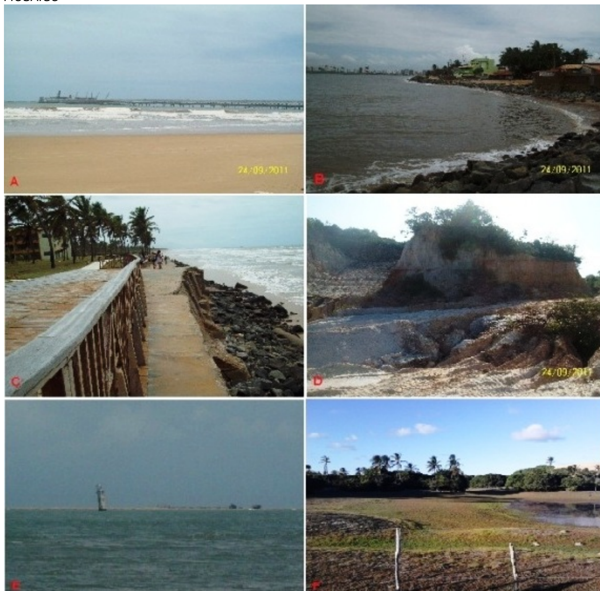
Figura 02 – Mosaico representativo das derivações antropogênicas nos municípios do litoral norte do estado de Sergipe (foto A- Obras de engenharia intervenientes na dinâmica costeira do estuário do Rio Sergipe no Município de Barra dos Coqueiros; foto B e C – Erosão costeira no município de Barra dos Coqueiros; foto D – Processo erosivo de vossorocamento gerado a partir da construção de uma estrada no município de Pirambu; foto E – Margem direita da Foz do rio São Francisco, Brejo Grande – SE (antigo povoado cabeço); foto F-
